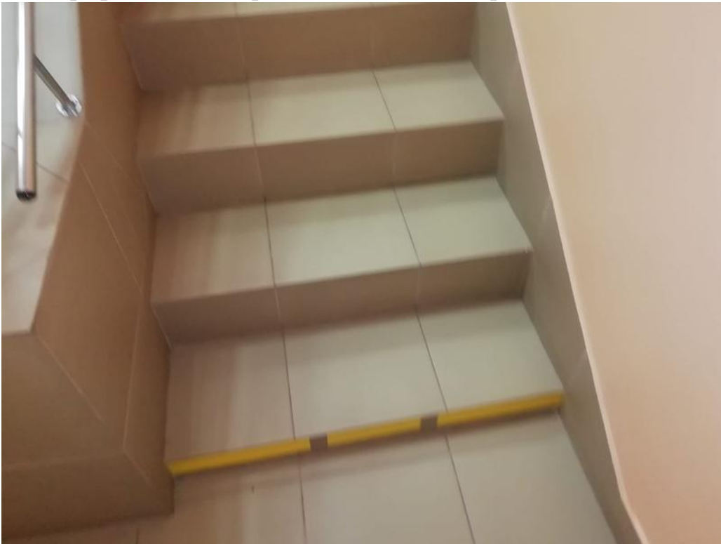
Фотография №2 Начало лестницы на второй этаж
